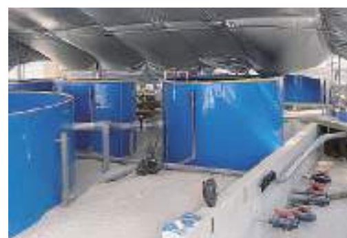
PP管、塩ビ管による配水管敷設
