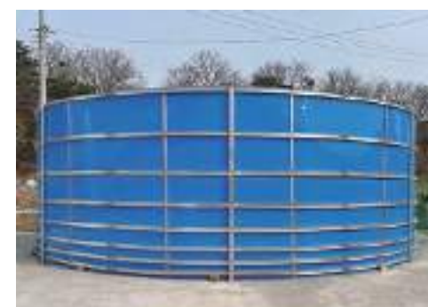
円形水槽 + 補強
