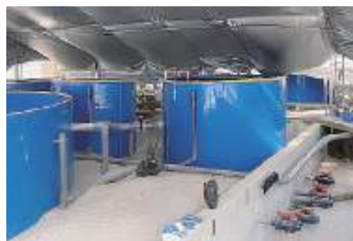
PP管、塩ビ管による配水管敷設
